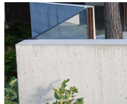
petits ouvrages béton
