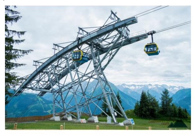
L'importance des pylônes semble surtout liée à la longueur du segment (poids à supporter et tension des câbles) et à la différence de pente entre les deux extrémités du pylône ; et le virage ne semble pas changer de façon importante le dimensionnement du pylône.
