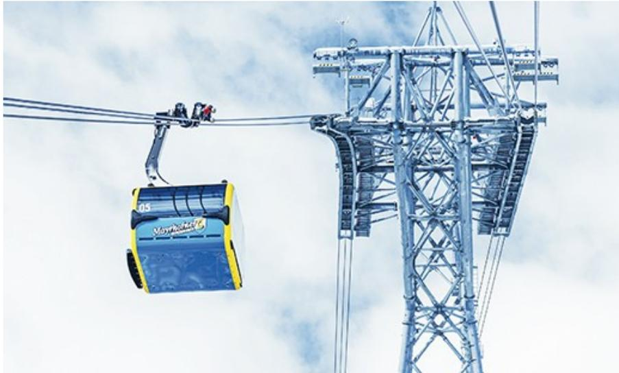
Pylône avec virage. L'inclinaison latérale éventuelle n'est pas visible, alors que la ligne est comparable aux tronçons du Funiflaine (longueur 3km, dénivelé 1100m, 3 pylônes). La longueur du sabot est de 50m.
