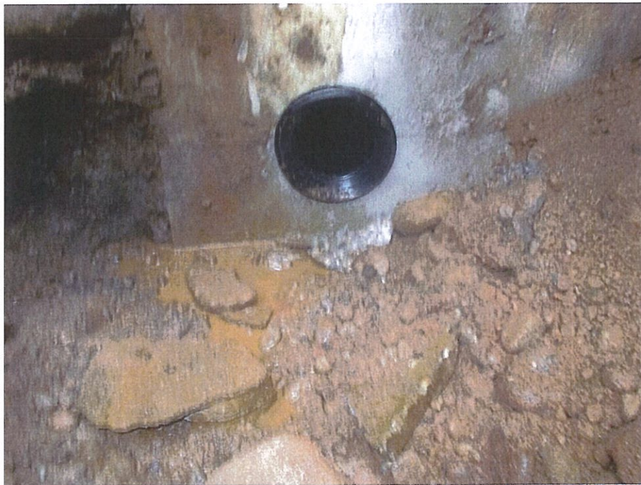
Mise en place du joint Forsheda prêt à recevoir le tuyau
