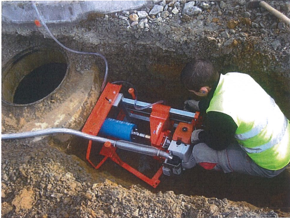
Carottage du regard existant ou créé
