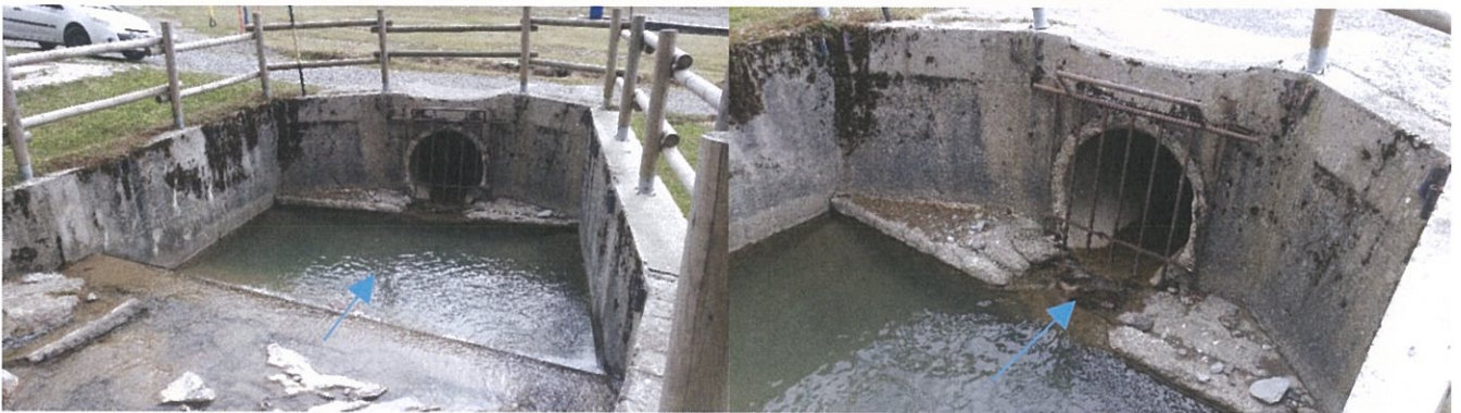
Figure 8 : Arrivée sur la buse aval béton
