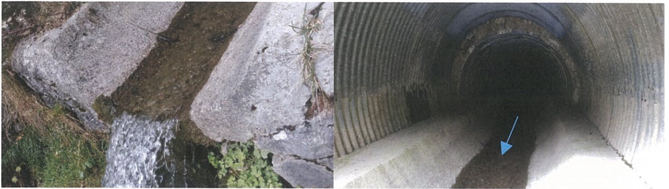
Figure 7 : Débouché de la buse métallique
