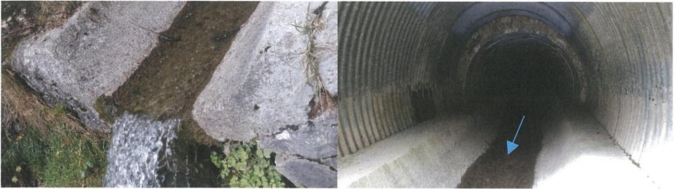
Figure 7 : Débouché de la buse métallique
