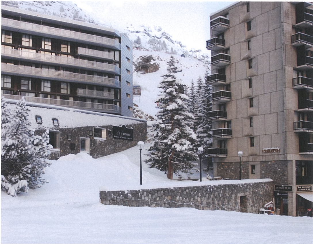
Vue du Forum sur Centaure et Aldébaran - (Source R architecture) matériaux : Béton brut, Pierre de Sixt en sousbassement, acier Inoxydable
