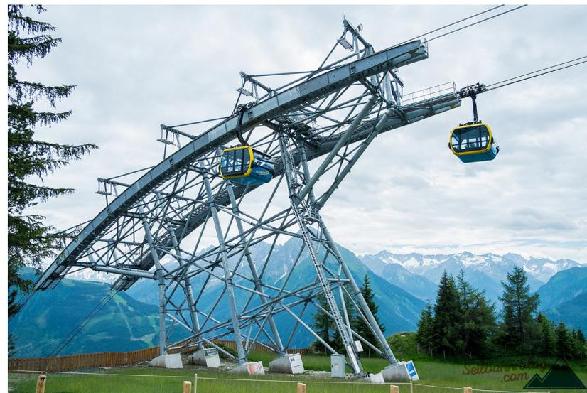
Pylône avec virage de 6°. L'inclinaison latérale éventuelle n'est pas visible, alors que la ligne est comparable aux tronçons du Funiflaine (longueur 3km, dénivelé 1100m, 3 pylônes). La longueur du sabot est de 50m.
