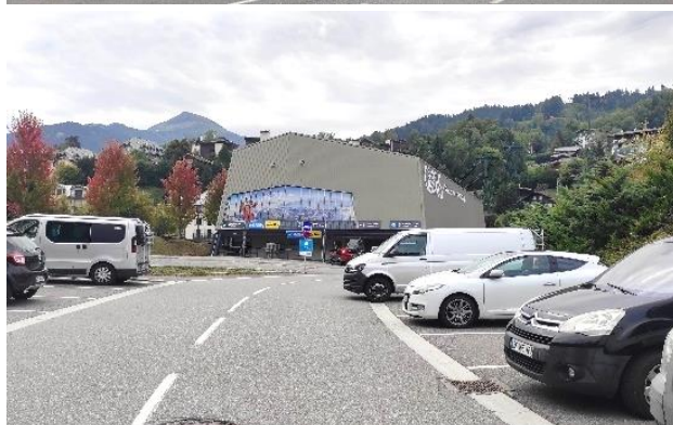
Vue actuelle de la gare aval du DMC (Châtelet)
