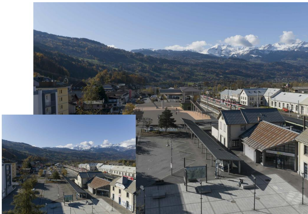
Projet d'insertion du bâtiment abritant la gare aval de l'ascenseur valléen au Fayet
