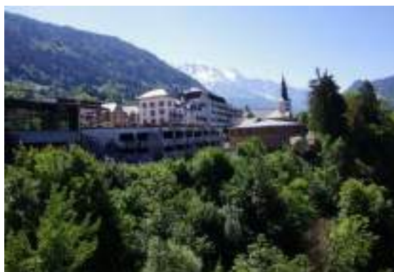
Photo 51 La perception du parking en dessous de l'esplanade
