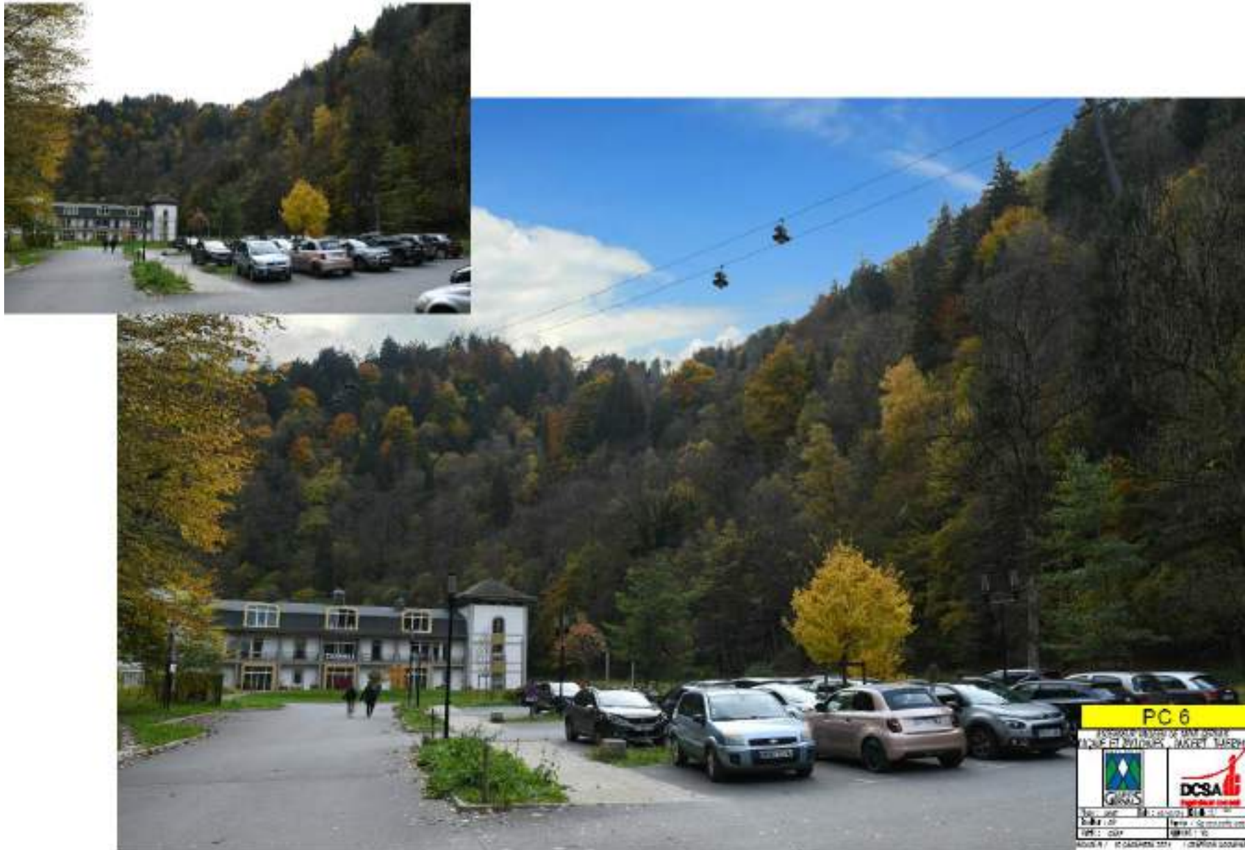
Photo 6 Insertion de la ligne entre les pylones P8 et P9, vue depuis les thermes
