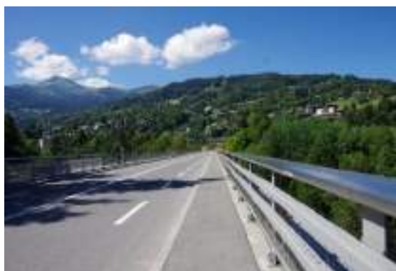
Photo 46 Perception lointaine sur le coteau urbanisé du Neyret via le nouvel ouvrage d'art
