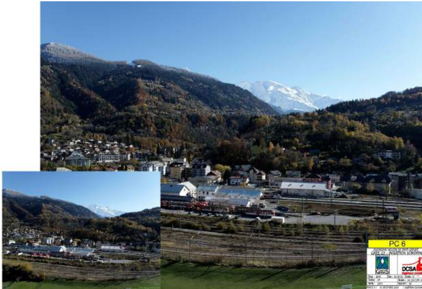
Photo 67 Vue sur les Pylônes P2 et P3 depuis le nord de la gare SNCF, dans l'aire de covisibilité présentée sur la Carte 89
