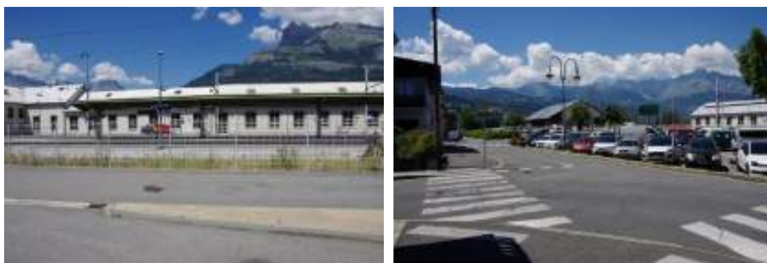
Photo 62 Ambiance dédiée à la mobilité. A gauche, les bâtiments techniques de la gare. A droite, la gare et ses espaces de stationnements
