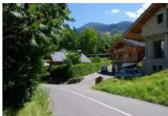
Photo 58 Possibilité de passage du projet en amont du Fayet d'en Haut, une conduite forcée est perceptible en bordure des parcelles
